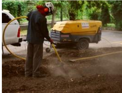
Pokaz prac w technologii sprężonego powietrza
